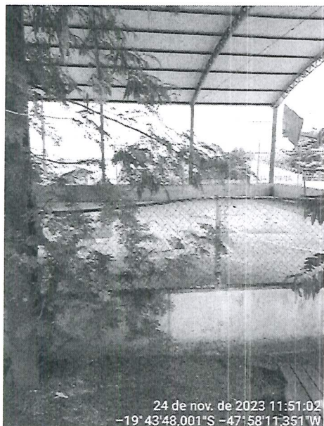
Figura 1: Leucena em conflito com a estrutura. Fonte: SEMAM, 2023.
